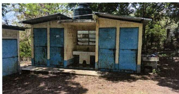
Foto 2: Mantenimiento de puertas, lijado, cepillado, dos manos de pintura anticorrosiva azul.
