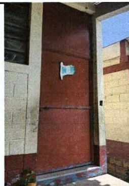
Foto 4: Mantenimiento de puertas, lijado, cepillado, dos manos de pintura anticorrosiva azul.
