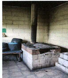
Foto 6: Mejoramiento de cocina de leña, forrada con piso cerámico, cambio de hornillas y chimenea, fundición de mesa de concreto.
