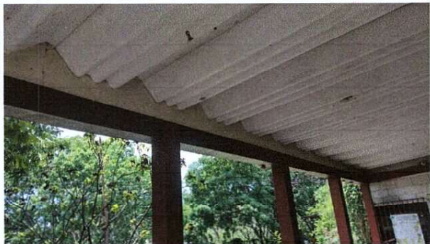
Foto 1: Mejoramiento de techo e instalación de estructura metálica y lámina
