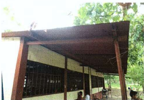
Foto 3: Cambio e instalación de lámina, mantenimiento y pintura a estructura metálica.
