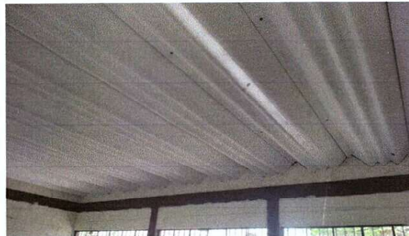
Foto 2: Mejoramiento de muros demolición y nivelado para instalación de estructura metálica y lámina.
