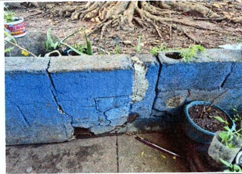
Foto 2: SUSTITUCIÓN DE MURO PASAMANO
