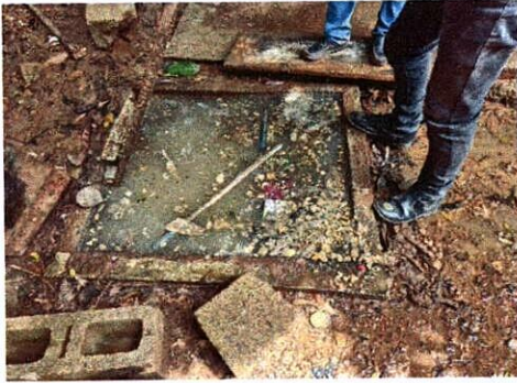
Foto1: SUSTITUCIÓN REPOSADERA
