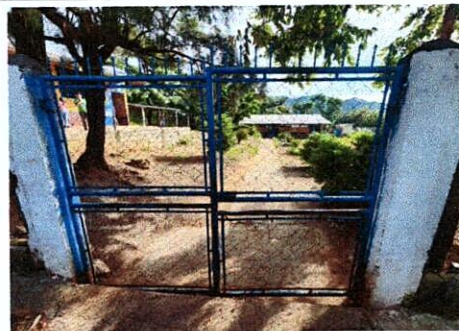
Foto 6: SUSTITUCIÓN DE PORTON METAL PRINCIPAL
