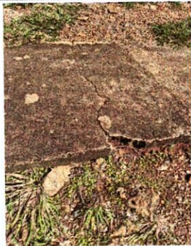
Foto 3: SUSTITUCIÓN LOSA DE PATIO, ACCESO PRINCIPAL
