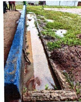
Foto 4: SUSTITUCIÓN DE CUNETA CONCRETO
