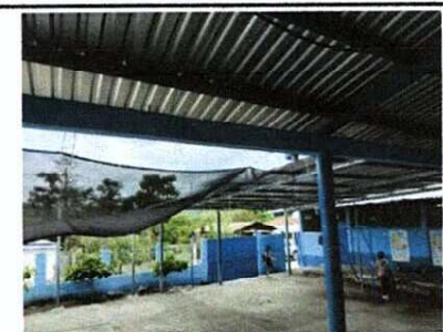
SUMINISTRO E INSTALACION DE GALERA DE ESTRUCTURA METALICA + LAMINA TROQUELADA CALIBRE 28
