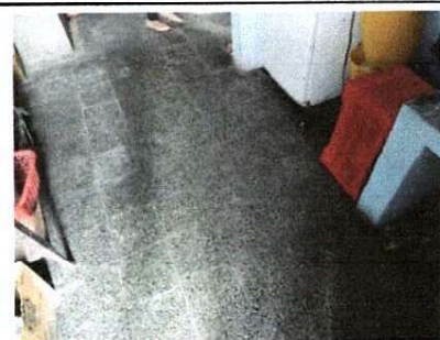
REMOZAMIENTO (QUE INCLUYE, PISO, MEJORAMIENTO DE PARED, INSTALACION ELECTRICA FUERZA E ILUMINACION, ESTANTERIA Y MEJORAMIENTO DE UBICACIÓN DE ELEMENTOS DE LA COCINA)
