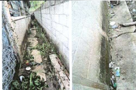
APLICACIÓN DE IMPERMEABILIZACION PARA DESFOGUE DE AGUAS PLUVIALES Y SUMINISTRO DE MEDIA CAÑA DE CONCRETO.
