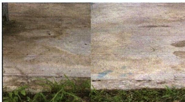
Foto 3: MEJORAMIENTO DE PISO DE CONCRETO
