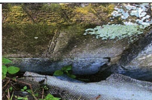
Foto 4: REPARACIÓN DE MURO DE BLOCK Y INTERMEDIAS Y COLUMNAS.
