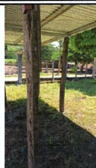
Foto 2: SUSTITUCIÓN DE ESTRUCTURA SOPORTE DE MADERA, POR METAL
