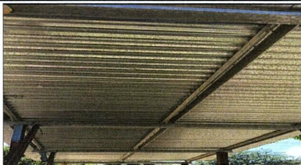
Foto 1: SUSTITUCIÓN DE LÁMINA, POR LÁMINA TROQUELADA ALUZINC CALIBRE 26 Y SUSTITUCIÓN DE ELMENTOS DE FIJACIÓN
