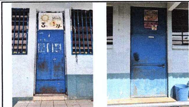
Foto1: MANTENIMIENTO Y REPARACIÓN A ESTRUCTURA EN PUESTAS METÁLICAS EN AULAS Y SANITARIOS
