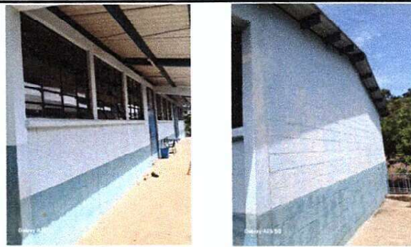
Foto 4: PINTURA GENERAL EN MUROS INTERIORES Y EXTERIORES DEL CENTRO EDUCATIVO
