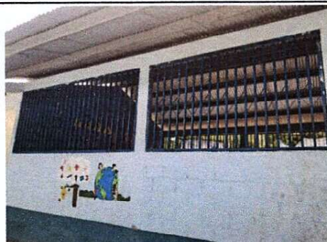
Foto 2: MANTENIMIENTO A ESTRUCTURA Y PINTURA EN VENTANAS TIPO BALCON
