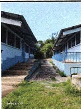
Foto 3: MEJORAMIENTO DE TECHO CON INSTALACIÓN DE CANAL METÁLICO CON BAJADAS DE AGUA PLUVIAL
