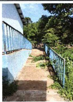
Foto 6: MANTENIMIENTO A BARANDAS DE METAL
