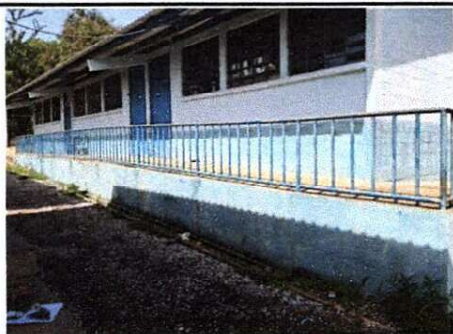
Foto 7: MANTENIMIENTO A BARANDAS DE METAL
