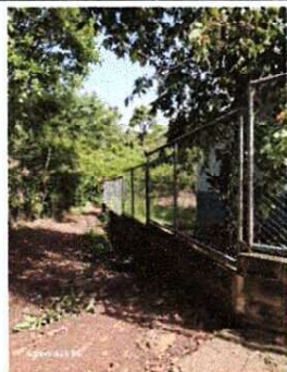
Foto 9: MEJORAMIENTO DE MURO PERIMETRAL DE BLOQUE Y MALLA GALVANIZADA MAS INSTALACIÓN DE CERCA RAZOR
