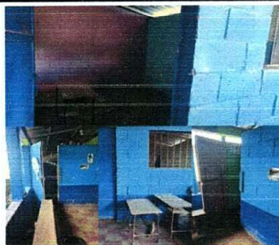
Foto 4: Remosamiento y ampliación a 2 aulas.
