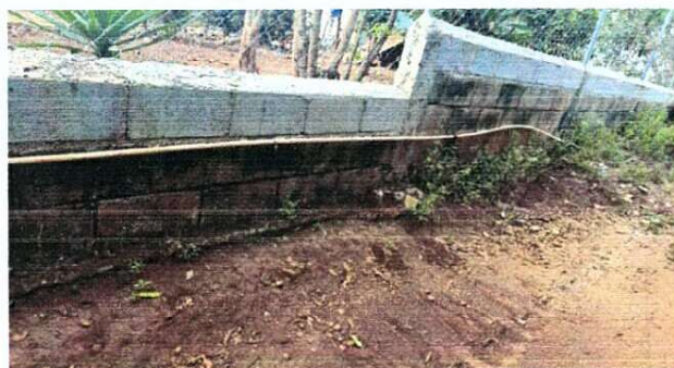
Foto 2: Remosamiento a la tubería del agua potable.
