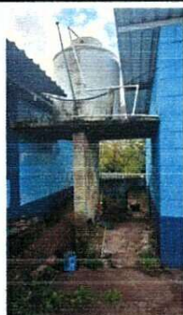
Foto 5: Adquisición de tinacos y construcción del area de lavandería y recolección de agua.
