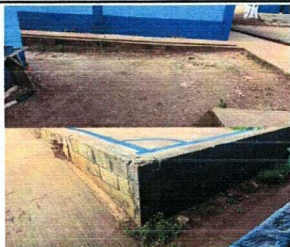
Foto 1: Remosamiento a la vías de acceso.
