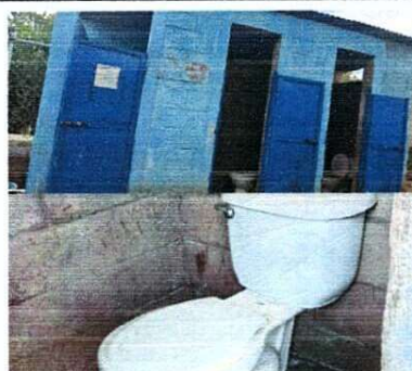
Foto 6: Remosamiento al área sanitaria.
