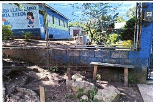
Foto 5: REPARACIÓN DE MURO PERIMETRAL
