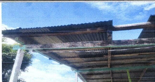
Foto 1: MEJORAMIENTO DE ESTRUCTURA DE TECHO
