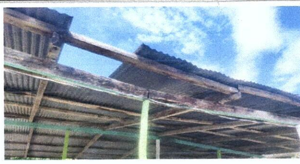
Foto 2: MEJORAMIENTO DE TECHO
