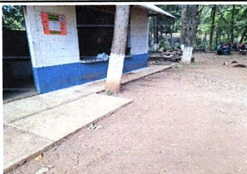
Foto 3: MEJORAMIENTO DE LOSA DE CONCRETO EN PATIO
