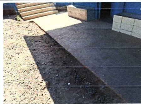
Foto 6: MEJORAMIENTO DE CUNETA DE CONCRETO
