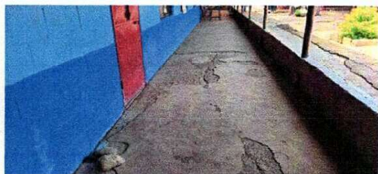
Foto 1: SUSTITUCION DE PISO DE CONCRETO
