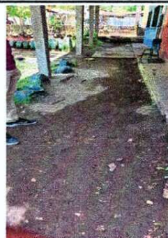
Foto 2: SUSTITUCIÓN DE PISO DE CONCRETO
