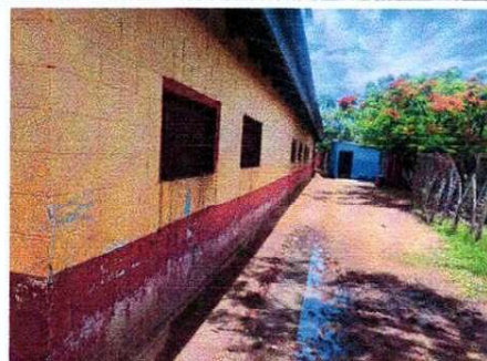
Foto 4: APLICACIÓN DE PINTURA EN MUROS EXTERIORES
