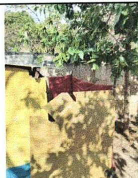
Foto 6: MEJORAMIENTO DE MURO DE SERVICIOS SANITARIOS
