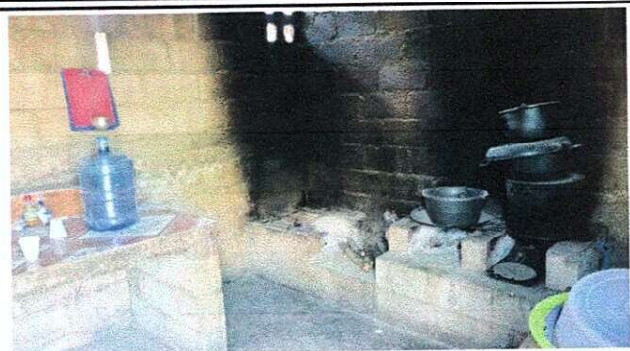
Foto1: MEJORAMIENTO DE COCINA RURAL + CHIMENEA
