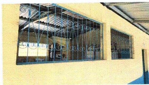
Foto 4: SUSTITUCIÓN DE BALCONES
