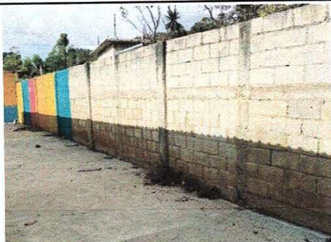
Foto 5: MEJORAMIENTO DE MURO DE BLOCK
