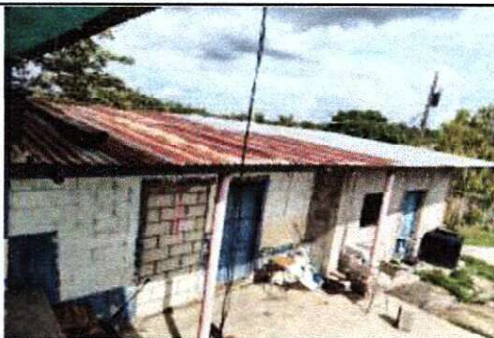
Foto 5: Sustitución de lamina en cocina y dirección
