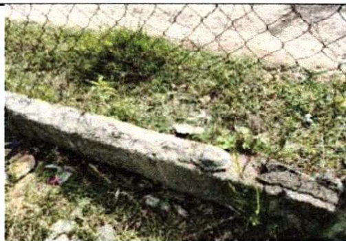
Foto 4: Reparación de muro perimetral de block
