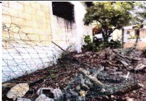
Foto 2: Reparación de muro perimetral de block
