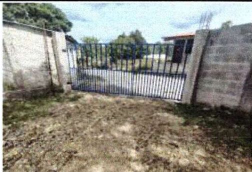
Foto 1: Mantenimiento de portón
