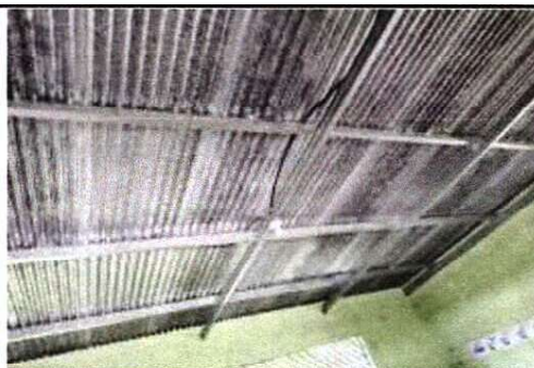
Foto 6: Sustitución de techo lamina troquelada
