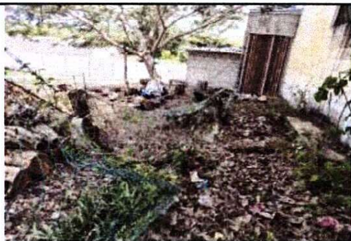
Foto 3: Mantenimiento en columnas de concreto
