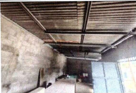
Foto1: Sustitución por lamina troquelada en cocina
