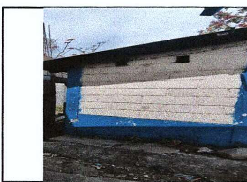
Foto 6: MEJORAMIENTO DE PISO DE CONCRETO
