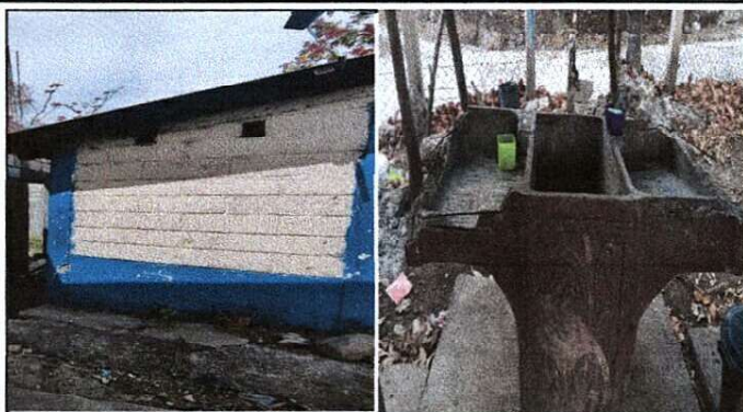
Foto 2: MEJORAMIENTO DE PISO DE CONCRETO, CAMBIO DE PILA Y MEJORAMIENTO E INSTALACION DE DRENAJE PARA PILA
