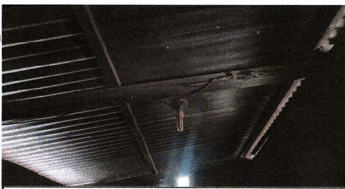
Foto 5: MEJORAMIENTO EN ESTRUCTURA DE TECHO COCINA, MEJORAMIENTO EN CUBIERA DE TECHO DE LAMINA ALUZINC COCINA
