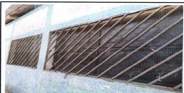
Foto 5: Fabricación e instalación de balcones de metal.
