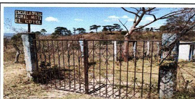
Foto 6: Mantenimiento y mejoramiento de porton principal
