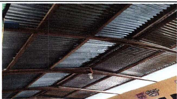
Foto1: Sustitución de estructura de techo de madera por metal
