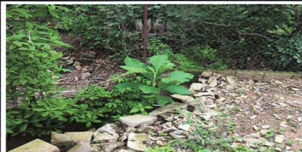
FOTO 4: REPARACION DE MURO PERIMETRAL DE BLOCK
