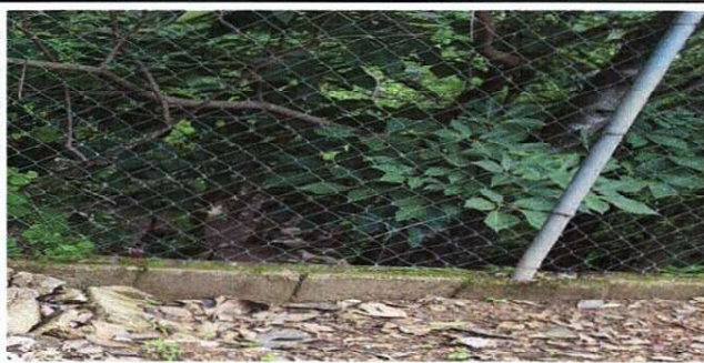
FOTO 3: REPARACION DE MURO PERIMETRAL DE BLOCK
