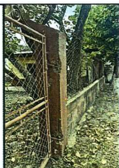
Sustitución de pintura en muro frontal
