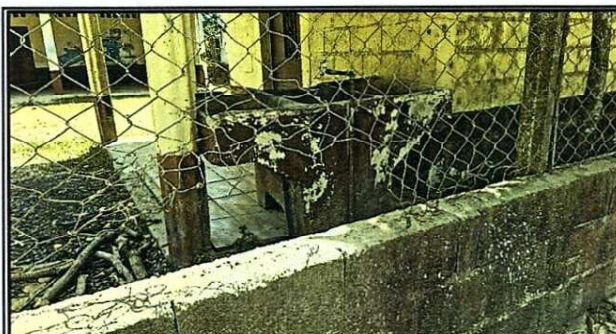
Reparación muro perimetral con maya galvanizada
