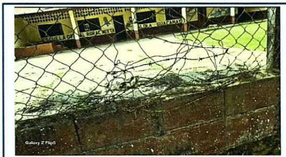
Foto1: Reparación de la circulación del muro perimetral de la escuela
