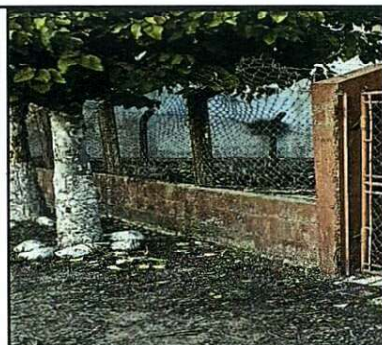
Foto 3: Reparación muro perimetral con block
