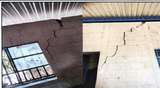
FOTO 1: Mejoramamiento y Reparación de muro columnas intermedias por fisuras, Demolición de muro por fisuras
