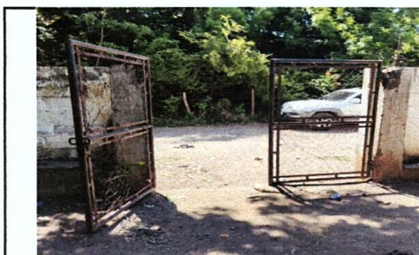
FOTO 10 :Sustitución de portón e instalación
