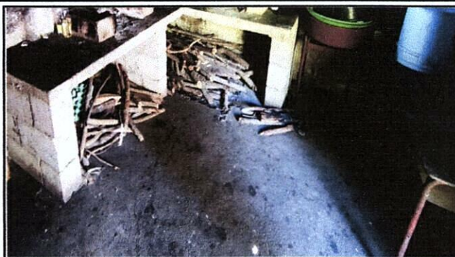
FOTO 8: Sustitución de torta de concreto a piso ceramico, Sustitución de lavatrastos
