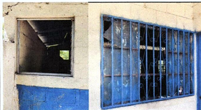
FOTO 3: Sustitución de ventanas de vidrio y aluminio por ventana pvc, Sustitución e intalación de balcón de metal
