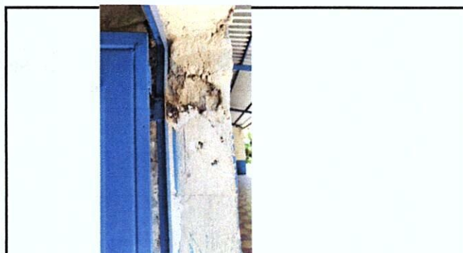
FOTO 9: Mantenimiento de a estructura puerta (Lijado, pintado, cambio de tubos)
