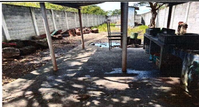
Foto: Mejoramiento de piso
