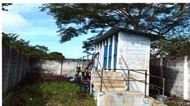
Foto: Sustitución y mantenimiento del sanitario
