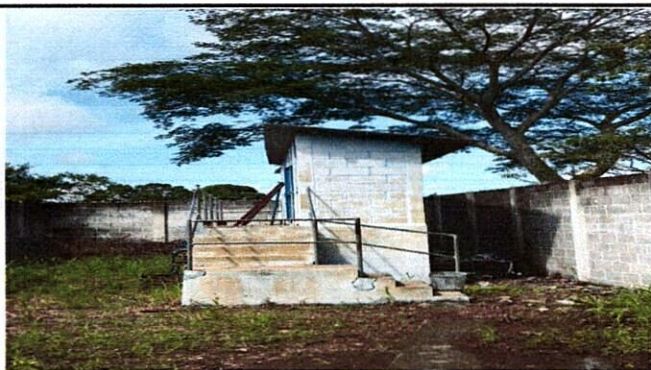
Foto: Sustitución por lámina troquelada
