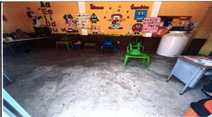
Foto: Mejoramiento de piso
