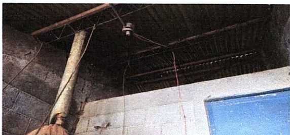
Foto 5: MEJORAMIENTO DE INSTALACIONES ELECTRICAS
