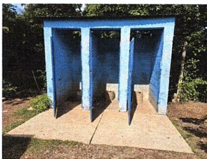
Foto1: SUSTITUCIÓN DE INODOROS
