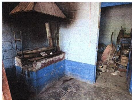
Foto 4: SUSTITUCIÓN DE ESTUFA RURAL COMPLETA
