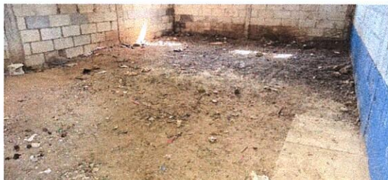
Foto 2: MEJORAMIENTO DE PISO DE CONCRETO
