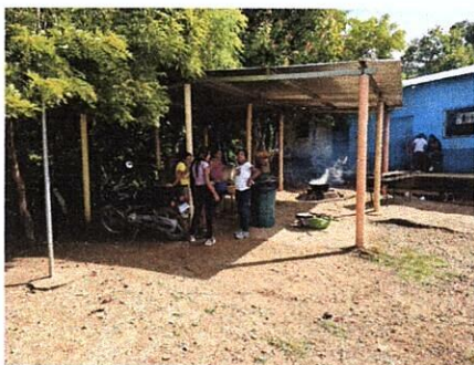
Foto 3: MEJORAMIENTO DE PISO DE CONCRETO
