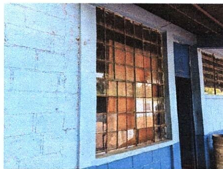
Foto 6: SUSTITUCIÓN DE VENTANA TIPO PERSIANA
