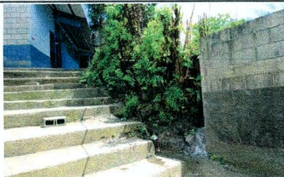
Foto 3: MEJORAMIENTO DE MURO PERIMETRAL DE BLOCK
