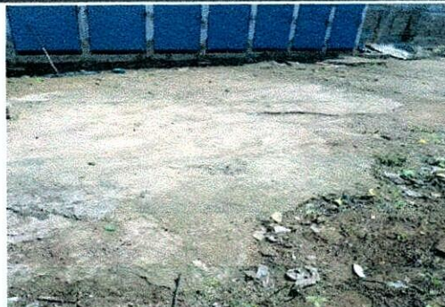
Foto 4: DEMOLICIÓN Y SUSTITUCIÓN DE PISO DE TORTA DE CONCRETO
