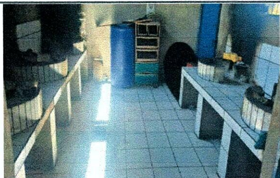
Foto1: MEJORAMIENTO DE ESTUFA RURAL Y MUROS EN ÁREA DE COCINA
