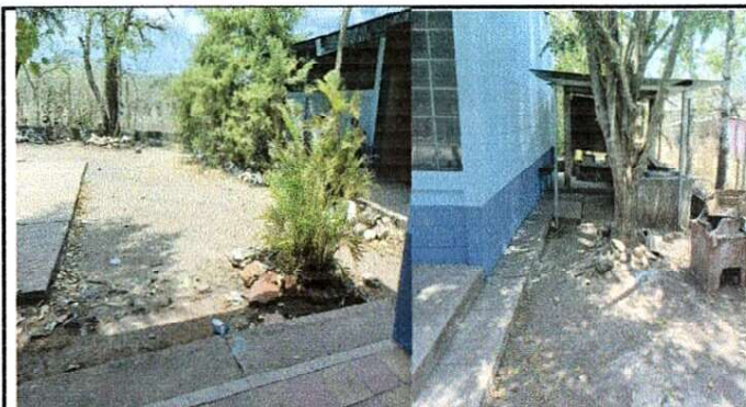
Foto 3: mejoramiento de torta de concreto patio y cocina
