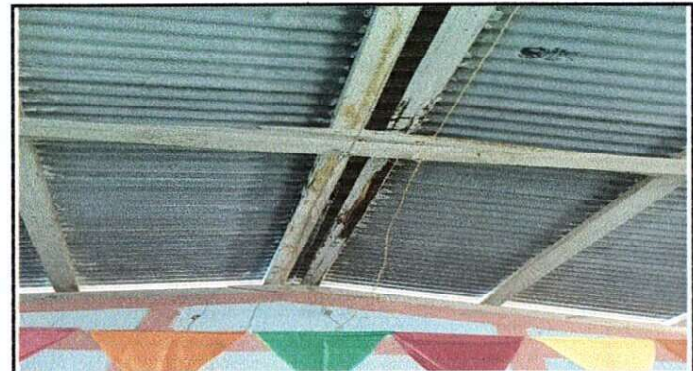
Foto 4: Mejoramiento de cableado de energía eléctrica, tomacorrientes, apagadores, bombillas
