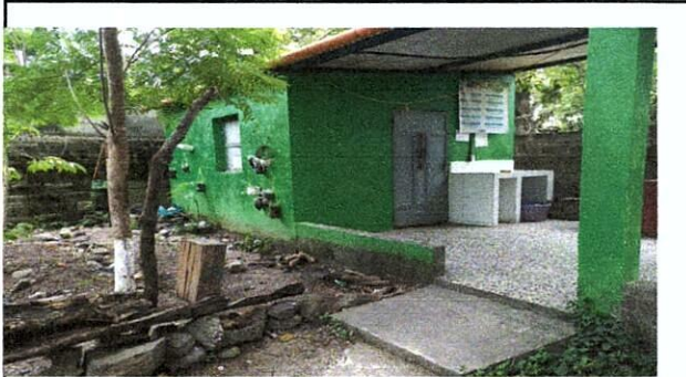
Foto 4: Colocacion dePuerta reja por lado dentro y balcon en la ventana
