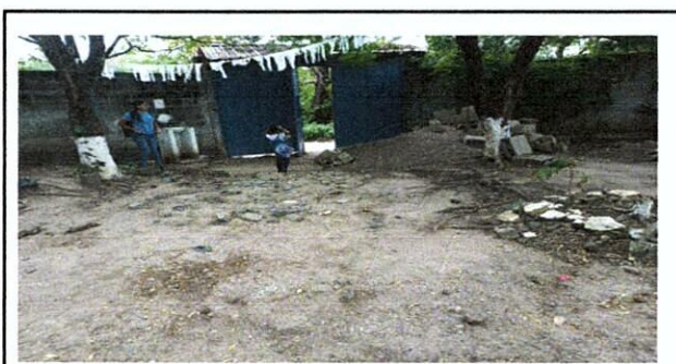
Foto 6: mejoramiento de la entrada del porton, colocacion de electromalla y reparación de la entrada del porton
