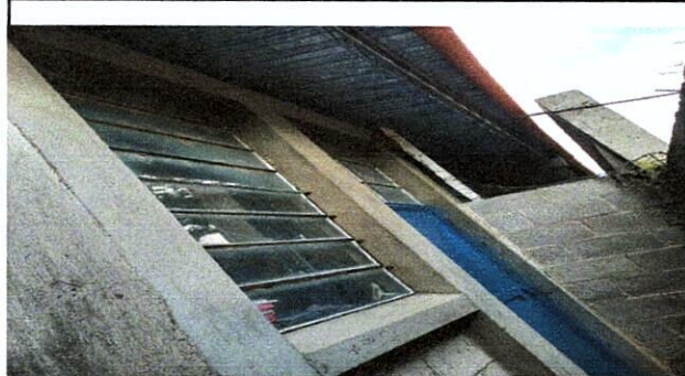
Foto 3: Balcon en la parte de atrás de la bodega del modulo 2
