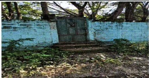
Foto1: Colocación de chapa y mantenimiento de la puerta principal
