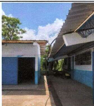
Foto 3: MEJORAMIENTO DE CANAL MAS INSTALACIÓN DE ACCESORIOS DE CONDUCCIÓN DE AGUAS PLUVIALES, BAJADA DE AGUA Y CAJA DE CAPTACIÓN
