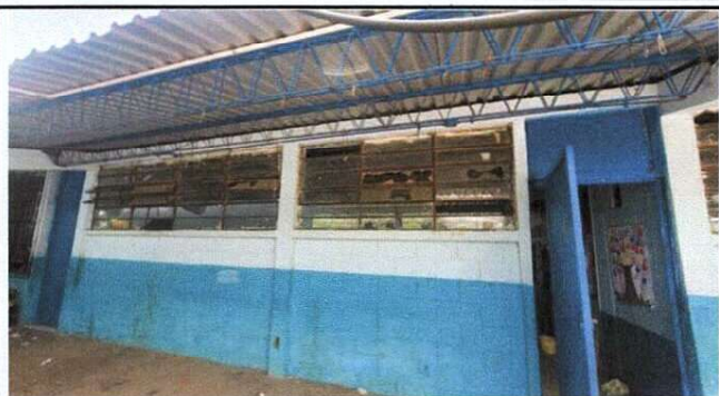
Foto1: SUSTITUCIÓN DE VENTANAS METÁLICAS CON VIDRIO POR VENTANAS DE PVC CORREDIZAS CON VIDRIO MAS INSTALACIÓN DE BALCONES
