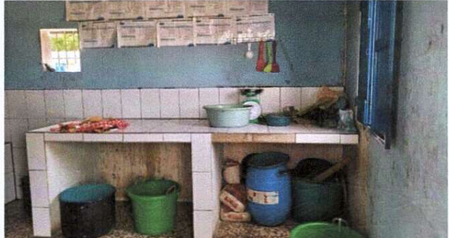
Foto 6: MEJORAMIENTO DEL AREA DE COCINA
