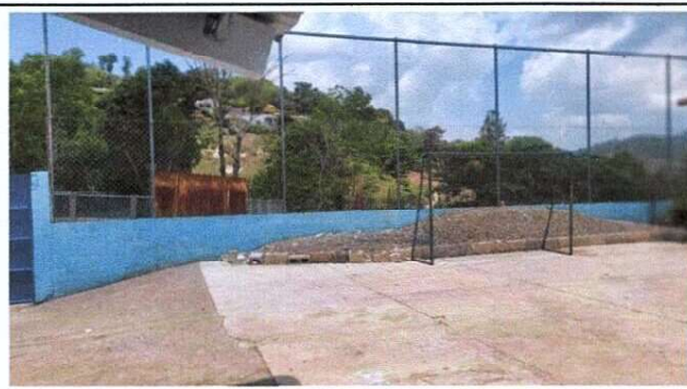
Foto 4: MEJORAMIENTO DE MURO PERIMETRAL DE BLOCK MAS INSTALACIÓN DE MALLA GALVANIZADA CON SOLERAS INTERMEDIAS.
