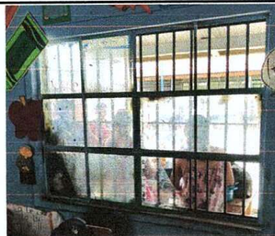
Foto 7: Sustitución de ventanas de metal por ventana pvc mas balcones de metal
