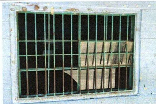
Foto 4: 1. Sustitución de Balcón de metal
