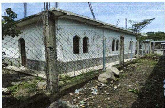
Foto1: Mejoramiento y repación de muro perimetral
