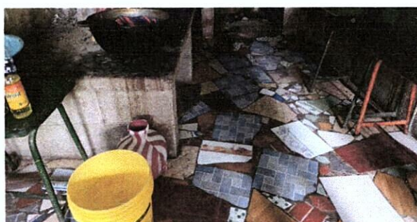
Foto 2: MEJORAMIENTO DE PISO CERÁMICO
