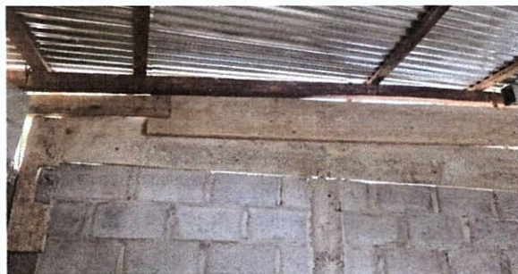
FOTO 6: MEJORAMIENTO DE MURO
