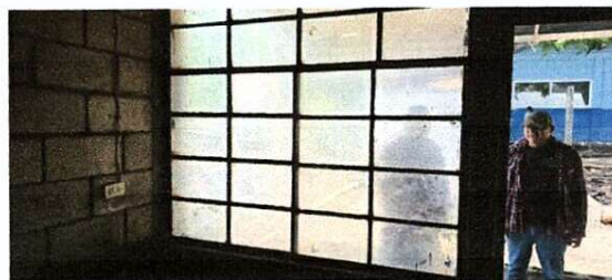
Foto 2: SUSTITUCIÓN DE VENTANA ✓
