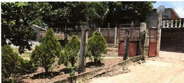
Foto1: MEJORAMIENTO MURO PERIMETRAL ✓
