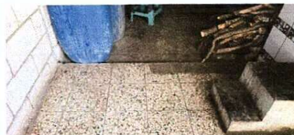
Foto 4: SUSTITUCIÓN DE PISO CERÁMICO ✓
