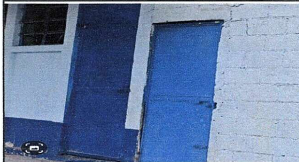
foto: mantenimiento de puertas , reparación, lijado y pintado.
