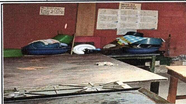
Foto: mejoramiento de mesa de concreto tipo isla con división intermedia, más instalación de azulejo.
