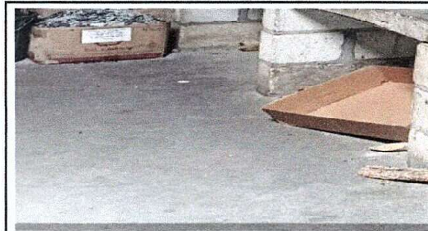
foto: reparación de piso de torta de concreto.
