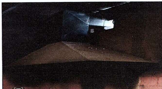
Foto: Mantenimiento de extractor de humo, lijado y pintura.
