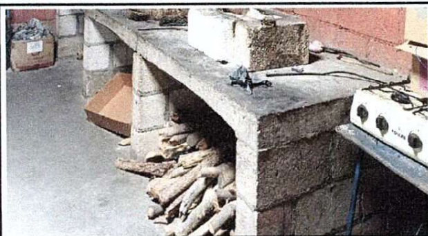
Foto: mejoramiento de piso, mas instalación de piso cerámico.
