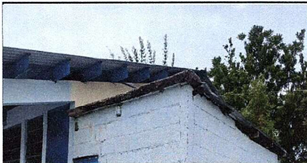
foto: sustitución de techo con instalación de estructura metálica y lamina troquelada calibre 26.
