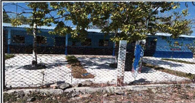
Foto 2: Reparación de muro perimetral
