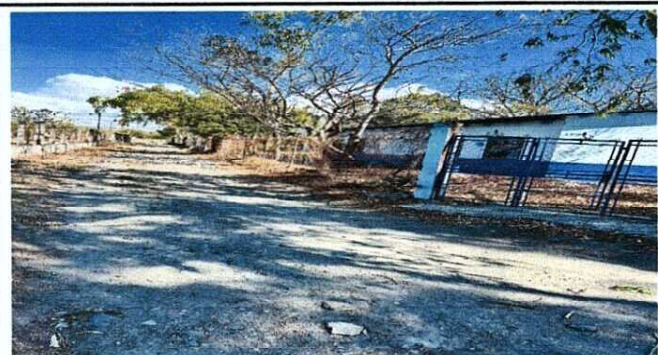
Foto 1: Reparación de muro perimetral
