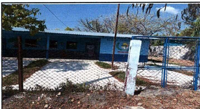
Foto 3: Reparación de muro perimetral
