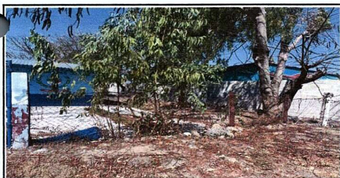
Foto 5: Reparación de muro perimetral
