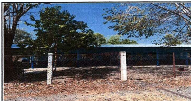
Foto 6: Reparación de muro perimetral
