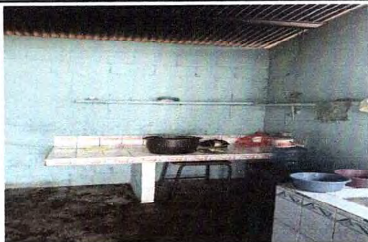
Foto 1: REPARACION DE COCINA
