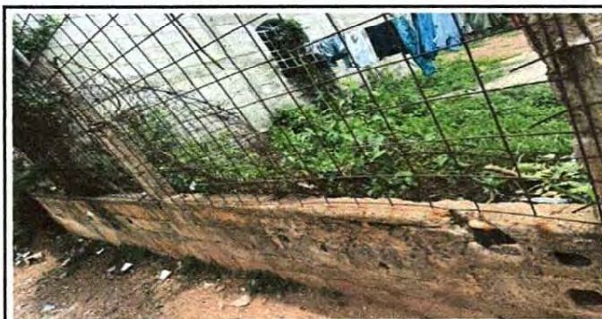
Foto 6: REPARACIÓN DE MURO DE CONTENCIÓN
