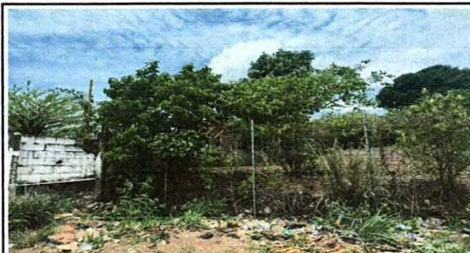
Foto 4: REPARACIÓN DE MURO DE CONTENCIÓN
