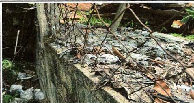
Foto1: REPARACIÓN DE MURO DE CONTENCIÓN
