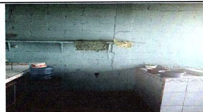
Foto 3: MEJORAMIENTO DE COCINA
