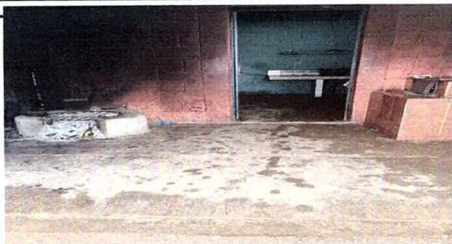
Foto 3: PINTURA DE MUROS
