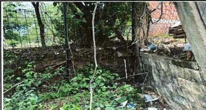
Foto 2: REPARACIÓN DE MURO DE CONTENCIÓN
