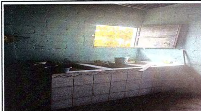
Foto 4: COLOCACION DE PILA
