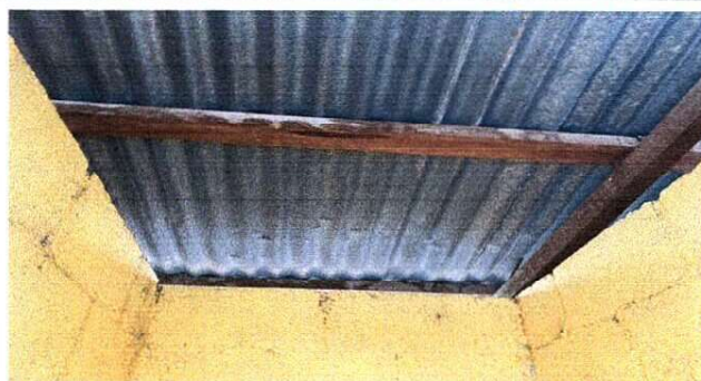
Foto 4: Reemplazo de techo en baños
