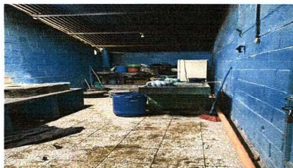
Foto 2: Suministro e instalación de drenajes y agua potable en cocina
