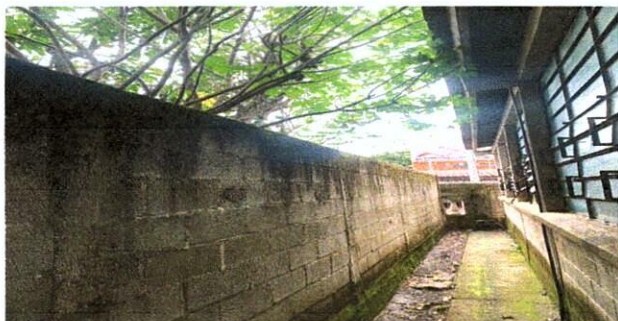
Foto 3: MEJORAMIENTO DE MURO DE BLOCK
