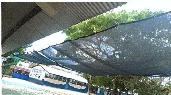
Foto1: MEJORAMIENTO DE CUBIERTA DE LÁMINA + ESTRUCTURA METÁLICA
