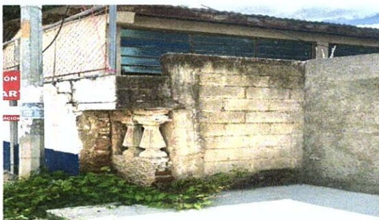
Foto 4: MEJORAMIENTO DE CERCA RAZOR
