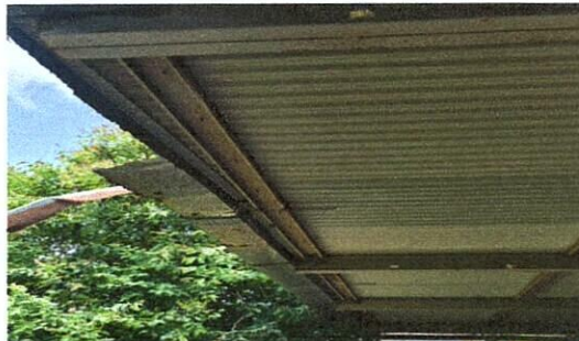
Foto 2: SUSTITUCIÓN DE CANAL METÁLICO
