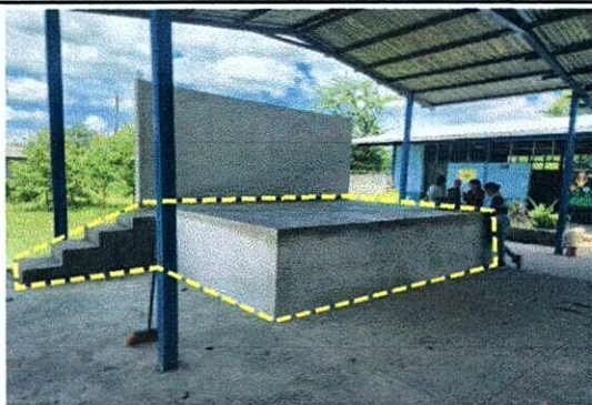
Foto 3: Vista panorámica del escenario, el cual se le va a colocar piso antideslizante y fachaleta, ambos de cerámica. Se muestra en recuadro amarillo el área a intervenir.
