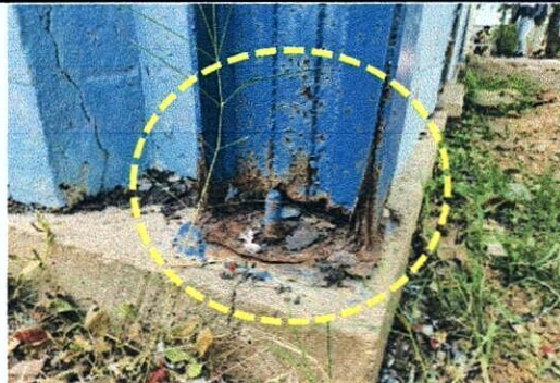
Foto 6: Vista de base de columnas a reforzar.
