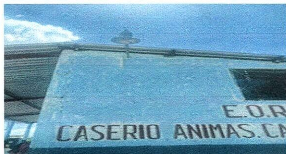
Foto: Mejoramiento de acometida eléctrica
