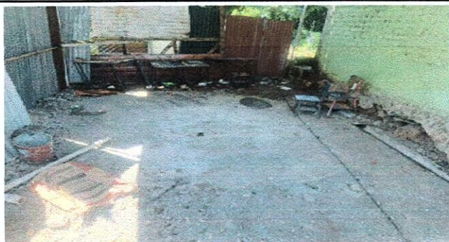
Foto; Sustitución de torta de concreto liso
