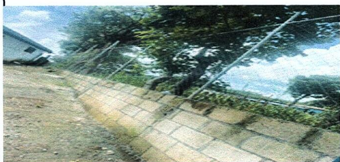
Foto: Mejoramiento de muro perimetral
