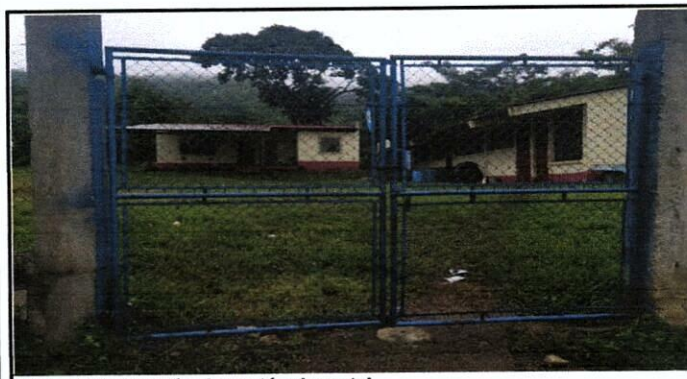
Foto 5: Sustrucción de portón de metal
