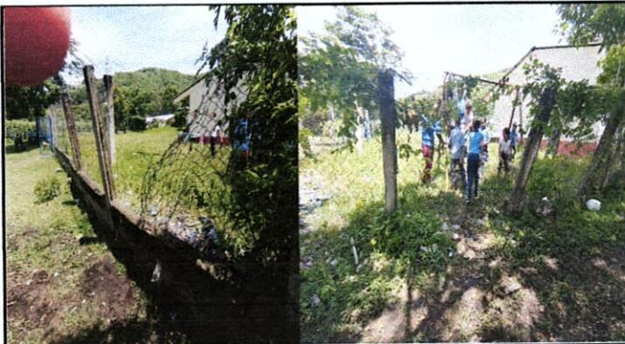
Foto 3: Mejoramiento de muro perimetral tipo block malla por muro perimetral block columnas e intermedias
