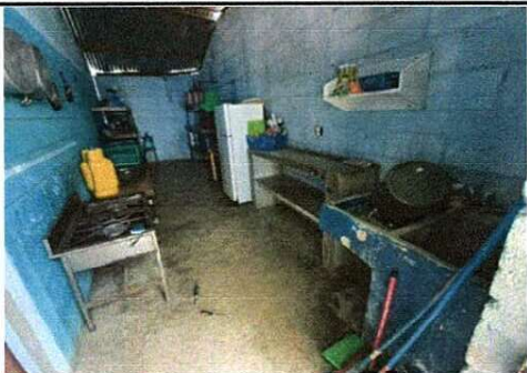
Foto1: MEJORAMIENTO DEL AREA DE COCINA
