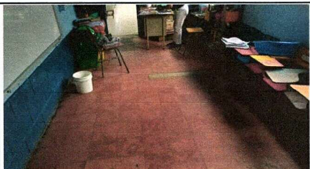
Foto 3: SUSTITUCIÓN DE PISO DE GRANITO POR PISO CERÁMICO
