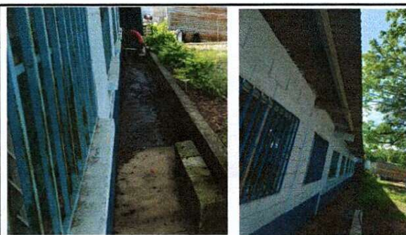
Foto 5: MEJORAMIENTO DE DRENAJE DE AGUAS PLUVIALES MAS INSTALACIÓN DE CANAL EN TECHO CON DESCARGA DIRECTA AL DRENAJE
