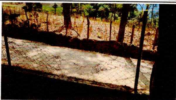
Foto 1: SUSTITUCIÓN DE CERCO PERIMETRAL CON BLOCK Y MALLA
