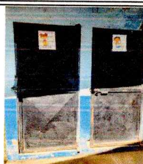
Foto 2: REPARACIÓN Y MANTENIMIENTO PUERTAS EN AREA DE BAÑO
