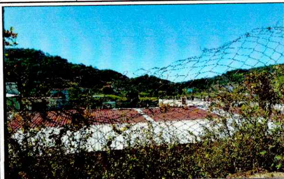
Foto1: Sustrucción de muro perimetral
