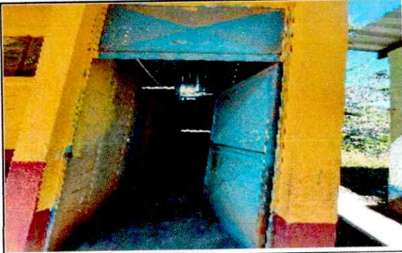
Foto 7: Reposición de chapas en puertas
