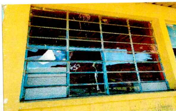
Foto 6: Sustrucción de vidrios de ventanas.
