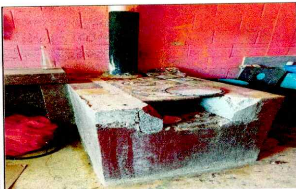
Foto 3: reparación de estufa rural.
