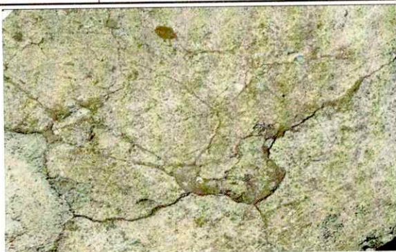
Foto 2: Sustrucción de losa de patio.
