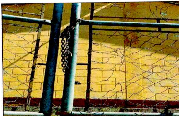
Foto 4: Reparación de porton.
