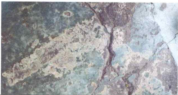
Foto 1: Sustrucción de piso
