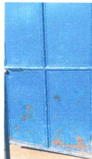
Foto 2: Mantenimiento de 6 puertas
