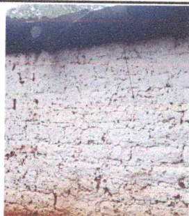
Foto 5: Sustitución y reparación de paredes en estado fragil y con grietas.
