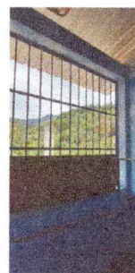
Foto 2: REPARACIÓN DE VENTANA DE LA COCINA
