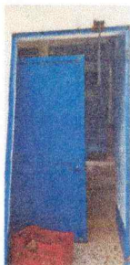
Foto 1: REPARACIÓN DE PUERTA DE LA COCINA
