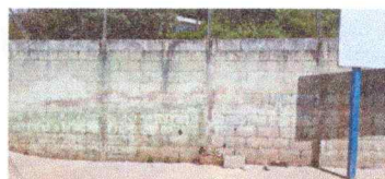
Foto 4: PINTURA DE MUROS Y 3 AULAS
