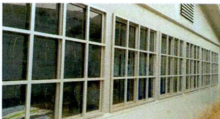
Foto 3: LIMPIEZA DE VENTANAS
