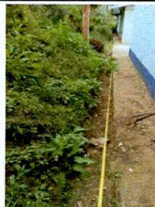
Foto 4: SUSTITUCIÓN DE CUNETA DE CONCRETO
