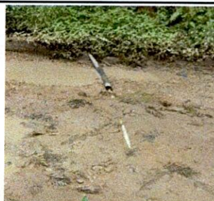
Foto 6: SUSTITUCIÓN DE DRENAJE DE AGUAS GRISAS INCLUYE ZANJAS TUBOS Y ACCESORIOS
