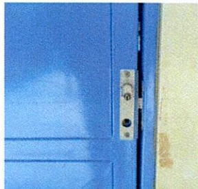
Foto 2: SUSTITUCIÓN DE MANIJA DE PUERTA CON CHAPA
