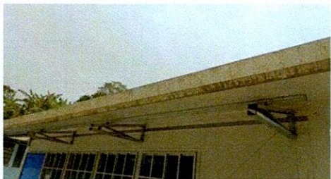
Foto 1: LIMPIEZA Y PINTURA DE CUBIERTA DE LÁMINA
