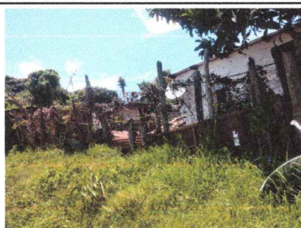
sustitucion de cerco
