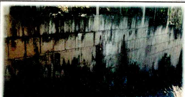
Foto 2: Reparación de muro perimetral
