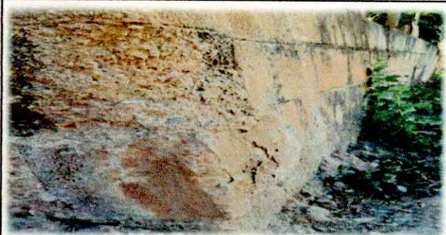
Foto 1: Reparación de muro perimetral
