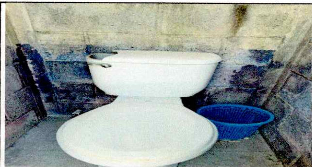
Foto 3: Sustitución de un servicio sanitario
