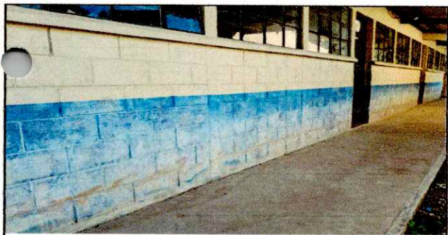
Foto 5: Sustitución de pintura de las aulas del establecimiento.
