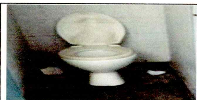
Foto 6: Sustitución de un servicio Sanitario en mal estado
