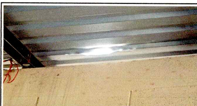
Foto 4: Sustitución de 2 láminas rotas
