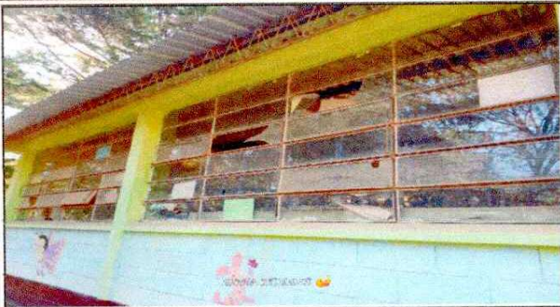
Foto 1: sustitución de vidrios en ventanas.
