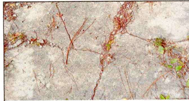
Foto 4: sustitución de losa de patio.
