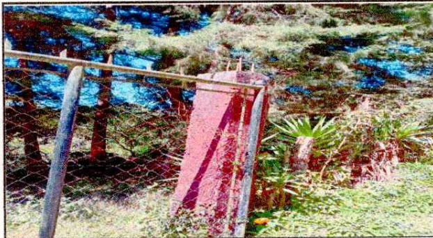
Foto 3: Reparación del porton.
