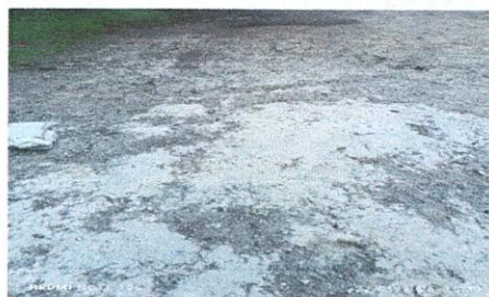
FOTO 6: SUSTITUCIÓN DE LOSA DE PATIO
