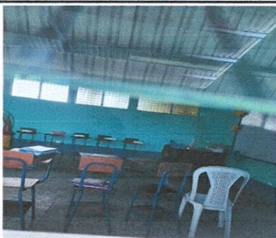
Foto 3: SUTITUCIÓN DE PINTURA DE MUROS INTERIOR Y EXTERIOR
