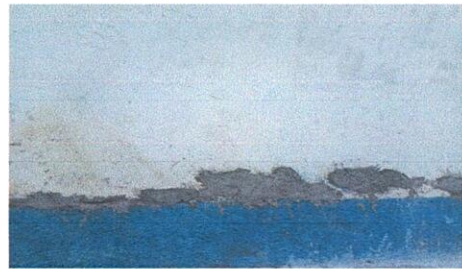
Foto 10: SUSTITUCIÓN DE REPELLO
