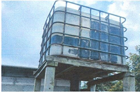
FOTO 7: SUSTITUCIÓN DE DEPOSITO DE AGUA
