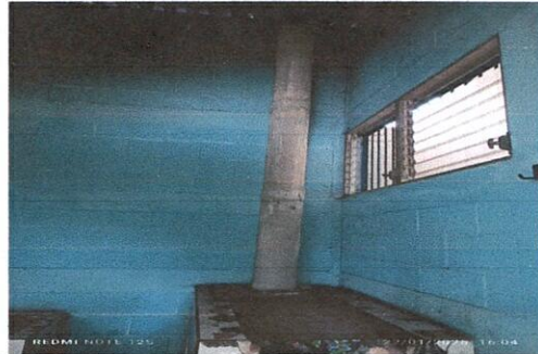
Foto 8: SUSTITUCION DE CHIMENEA DEL AREA DE COCINA
