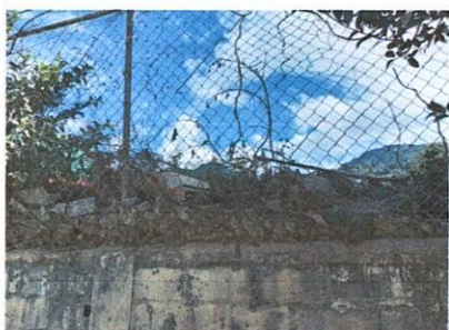
Foto 5: SUSTITUCION DE MURO PERIMETRAL
