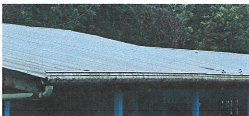
FOTO 1: SUSTITUCIÓN DE CANALES Y BAJADAS DE AGUA PLUVIAL
