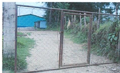
Foto 4: SUSTITUCIÓN DE PORTON DE ENTRADA
