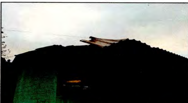
Foto 3: Cubierta de lámina. Sustrución de techo deteriorado por lámina aluzinc troquelada, calibre 26, de 10', 11' y 17'.
