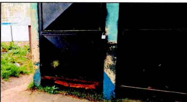
Foto 5: Puertas. Reparación y/o mantenimiento (desmontar, lijar o sustituir áreas oxidadas, limpiar, pintar y aplicar lubricante).
