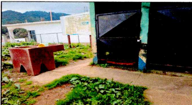
Foto 13: Reparación de red de drenajes y red de agua potable (reposición de pila y mantenimiento a red de desfogue de aguas servidas).
