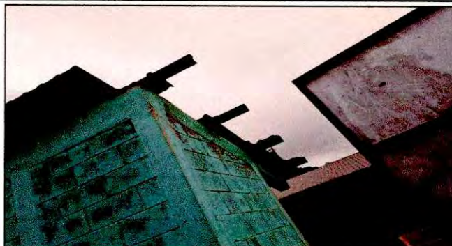
Foto 2: Cubierta de lámina. Sustrución de techo deteriorado por lámina aluzinc troquelada, calibre 26, de 10', 11' y 17'.
