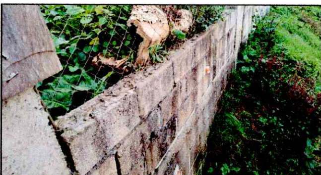
Foto 15: Cerco o muro perimetral. Reemplazo de muro proclive a colapsar o derrumbarse por otro mejor sujetado o de mayor seguridad.
