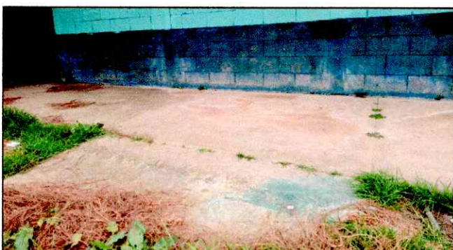
Foto 18: Losa de patio. Restitución de áreas con presencia de maleza y mejora en espacio tridimensional para garantizar la inclusividad al facilitar el acceso a personas con capacidades diferentes.
