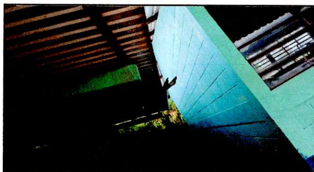
Foto 8: Canales y bajadas de agua pluvia. Sustruir el sistema deteriorado por canales y accesorios PVC.
