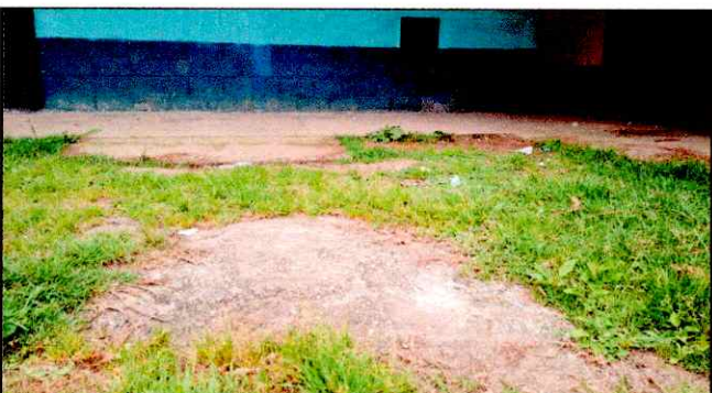
Foto 17: Losa de patio. Restitución de áreas con presencia de maleza y mejora en espacio tridimensional para garantizar la inclusividad al facilitar el acceso a personas con capacidades diferentes.
