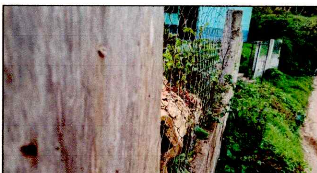
Foto 16: Cerco o muro perimetral. Reemplazo de muro proclive a colapsar o derrumbarse por otro mejor sujetado o de mayor seguridad.
