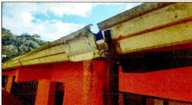
Foto 2: Sustitución de canales.
