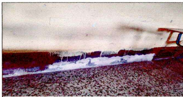
Foto 6: Sustitución de cernido y repello.
