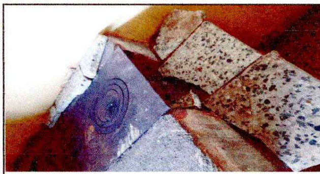
Foto 4: Reparacion de estufa rural.
