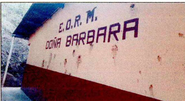
Foto 3: Sustitución de pintura en muros interiores y exteriores.
