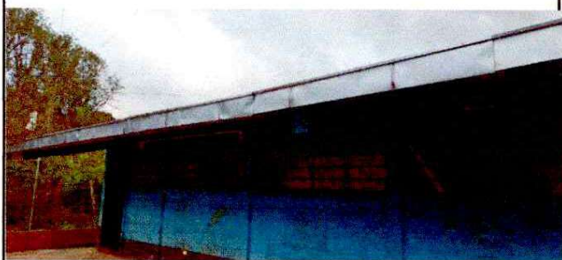
Foto 4: Sustitución de canales y bajadas de agua pluviales, ya que los actuales están deteriorados y no son funcionales
