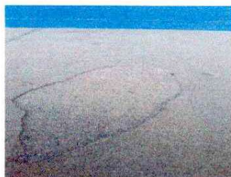
Foto 5: Losa de patio con deterioro. (algunas partes con grietas y otras con agujeros)
