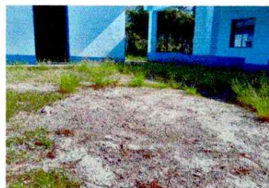
Foto 6: Losa de patio con deterioro (presenta desgaste por antigüedad)
