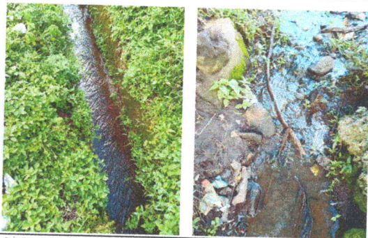
Foto1: Sustitución de cuneta de concreto
