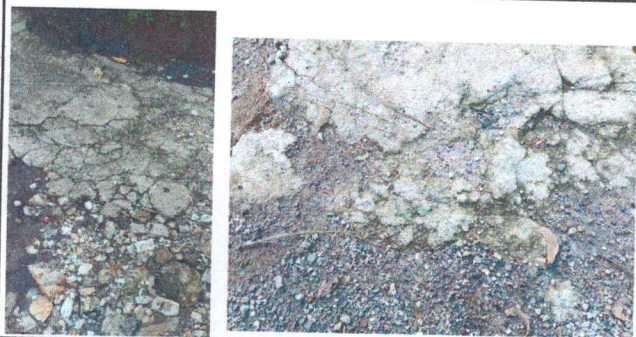
Foto 3: Sustitución de losa de patio
