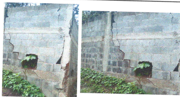
Foto 2: Sustitución de muro perimetral
