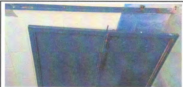
Foto 3: Reparación de puertas de baños
