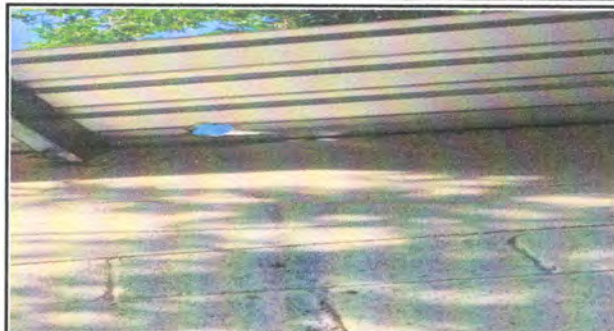
Foto 2: Reparación de lámina de techo
