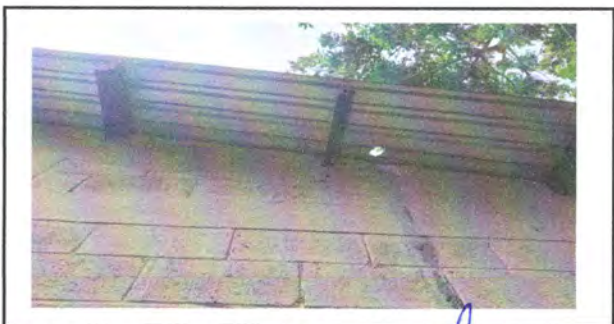
Foto 6: Sustitución de estructura de techo en área de eventos escolares
