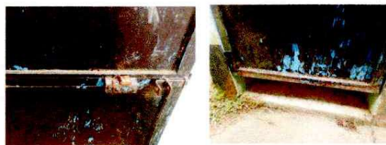
Foto 4: REPARACIÓN Y MANTENIMIENTO PUERTAS DE BAÑOS
