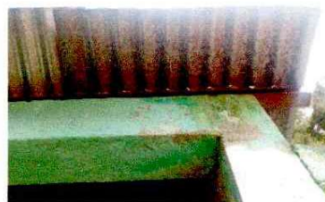
Foto 2: REPARACIÓN Y MANTENIMIENTO ESTRUCTURA DE TECHO, LIMPIEZA Y PINTURA
