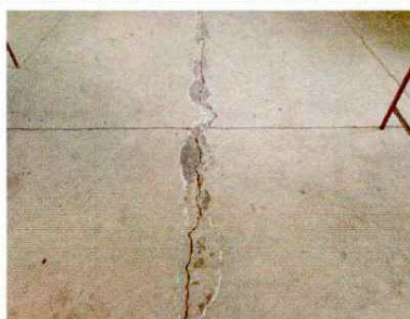
Foto 5: SUSTITUCIÓN PISO DE CEMENTO ALIZADO, INCLUYE DEMOLICIÓN, EXTRACCIÓN DE RIPIO, FUNDICIÓN Y TALLADO CON PINTURA EN POLVO
