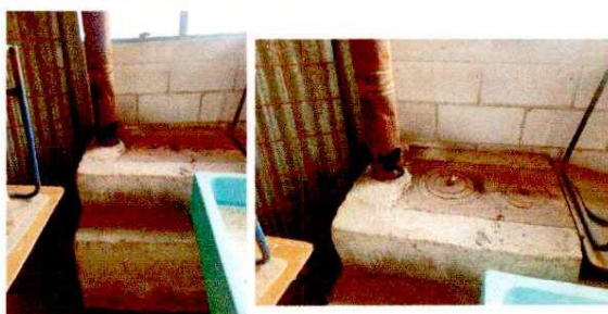
Foto 6: SUSTITUCIÓN DE ESTUFA RURAL CON SU CHIMENEA E INSTALACIÓN DE PILA
