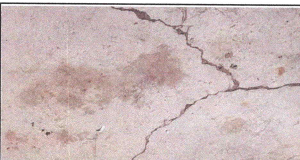
Foto 6: SE OBSERVA LOSA DE PATIO EN MALAS CONDICIONES
